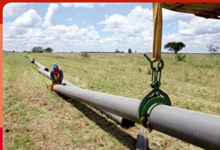
Mediante la aplicación de ensamble y unión de los tubos con materiales epóxicos, un equipo de apenas 12 trabajadores logró el tendido y la instalación promedio de 160 juntas al día, equivalentes a 1,9 kilómetros de recorrido. Este mismo rendimiento, con los métodos tradicionales de construcción requeriría las labores de 80 personas, incluidos soldadores, y un mayor volumen de desplazamiento de equipos, materiales y trabajadores.
