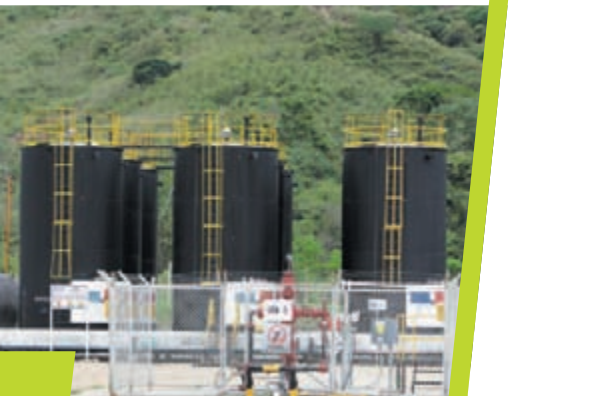
El manejo eficiente de los residuos de producción representó para la Compañía sustanciales ahorros económicos en 2012.
